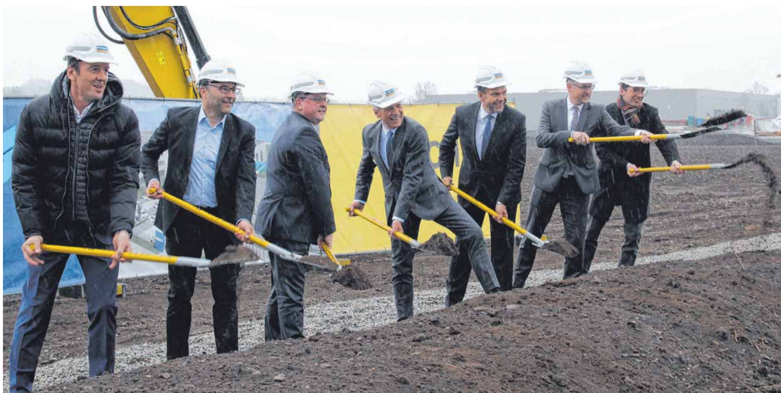
Auf dass die neuen Gebäude im Mai kommenden Jahres eingeweiht werden können: Vertreter des Bauunternehmens Reisch, die Geschäftsleitung der Firma Schunk und Bürgermeister Stefan Bubeck greifen beim Spatenstich zu den Schaufeln.
